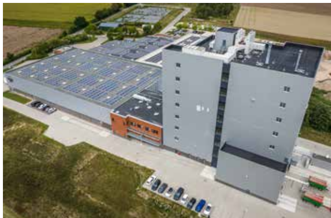
Über 4.000 Quadratmeter Solarmodule produzieren grünen Strom.
